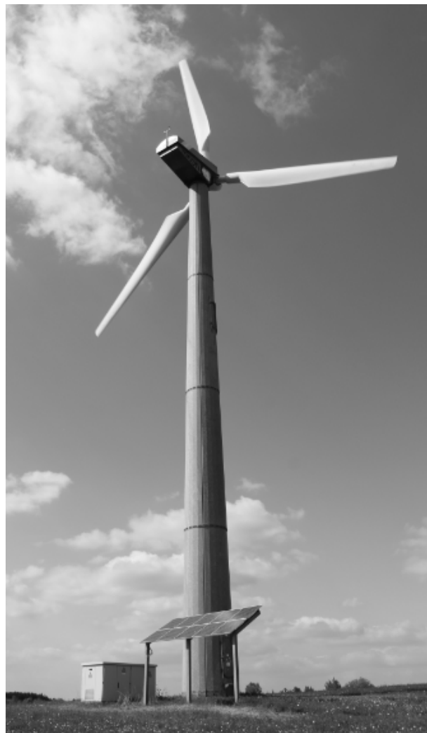
Windenergieanlage Herhahn I (1991) mit PV-Demonstrationsanlage (1995)
