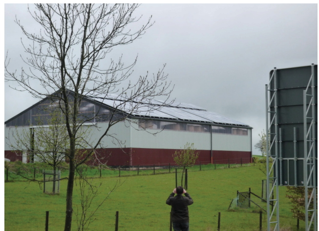
NEN PV-Anlage Zingsheim, 30 kWp ab Mai 2010
