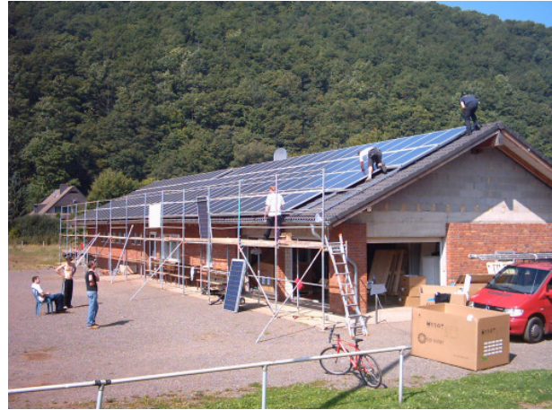
PV-Anlage Sportheim Nierfeld beim Aufbau
